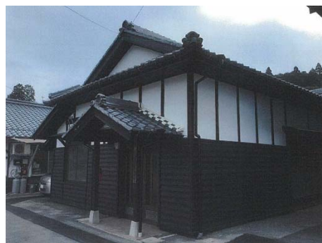
公民館外壁塗装
