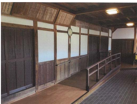
スロープ設置
