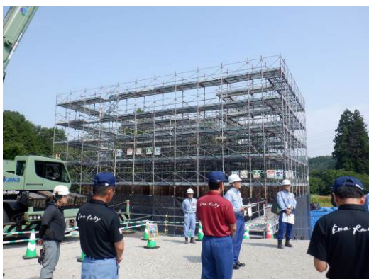
瑞浪恵那道路工事現場視察
