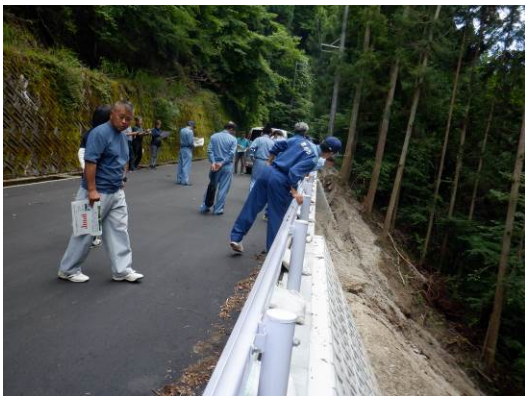
松本・中沢線災害復旧現場視察
