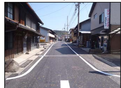
道路美装の様子
