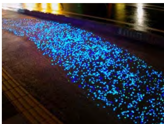
蓄光舗装（弁天橋）
