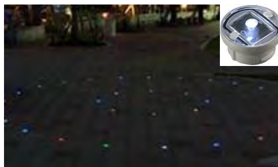
ソーラーLEDライト（敷石散策路法面）
