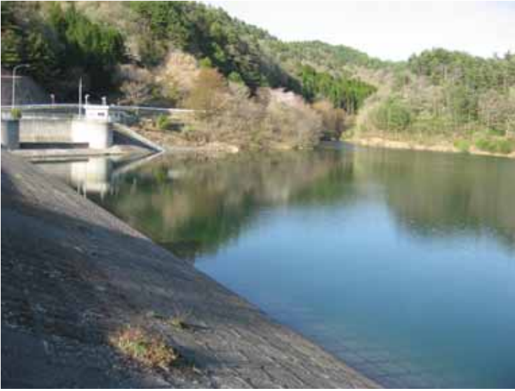
田沢防災ダム
