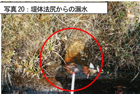
図 10：小段側溝部の堆砂、堤体下流法面からの水のしみだし
