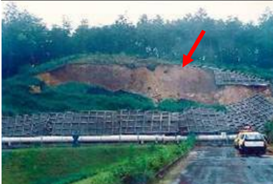
写真 38：堤体付近の法面(崩壊後)
