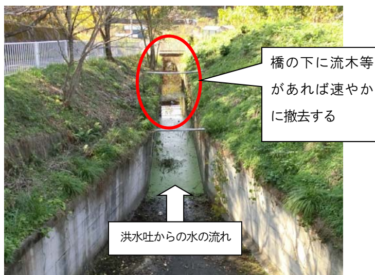
写真9：洪水吐下流水路の例
