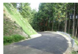
林道維持工事
