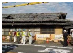
危険性が高い空き家
