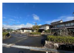
改修前の旧岩村振興事務所
