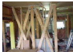
木造住宅耐震補強工事
