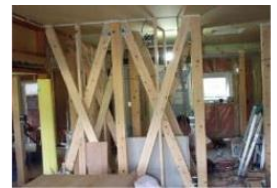
木造住宅耐震補強工事
