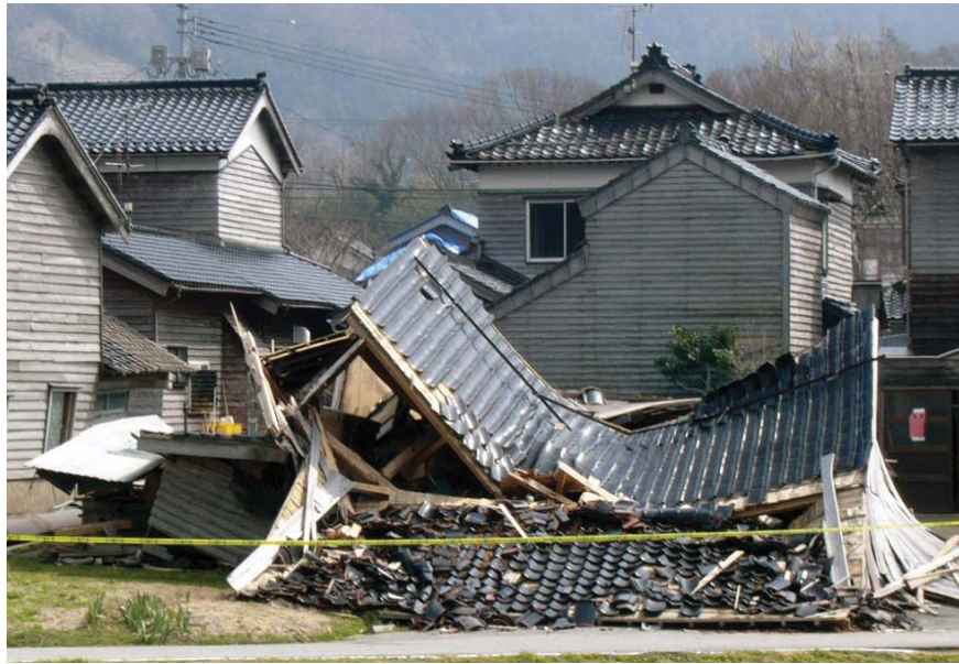
石川県能登半島地震による被害（輪島市内）
