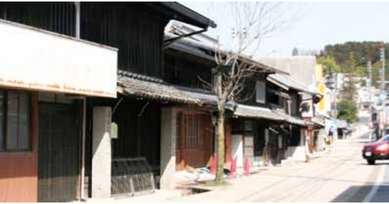
▲大井宿周辺に点在する町家建造物を調査
