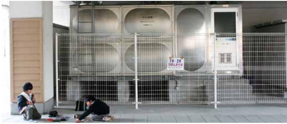
◀緊急用の弁を設置する大井小の受水槽
