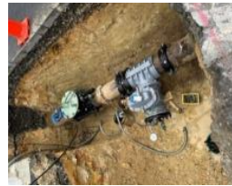
配水管の耐震化
