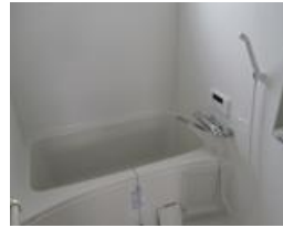
改修後の大洞市営住宅（ユニットバス）
