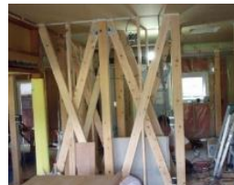
木造住宅耐震補強工事
