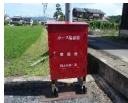
放水器具収納箱設置（イメージ）
