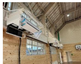
東野小学校屋内運動場の様子
