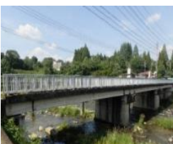
橋梁補修工事（河鹿橋）
