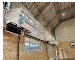
東野小学校屋内運動場の様子
