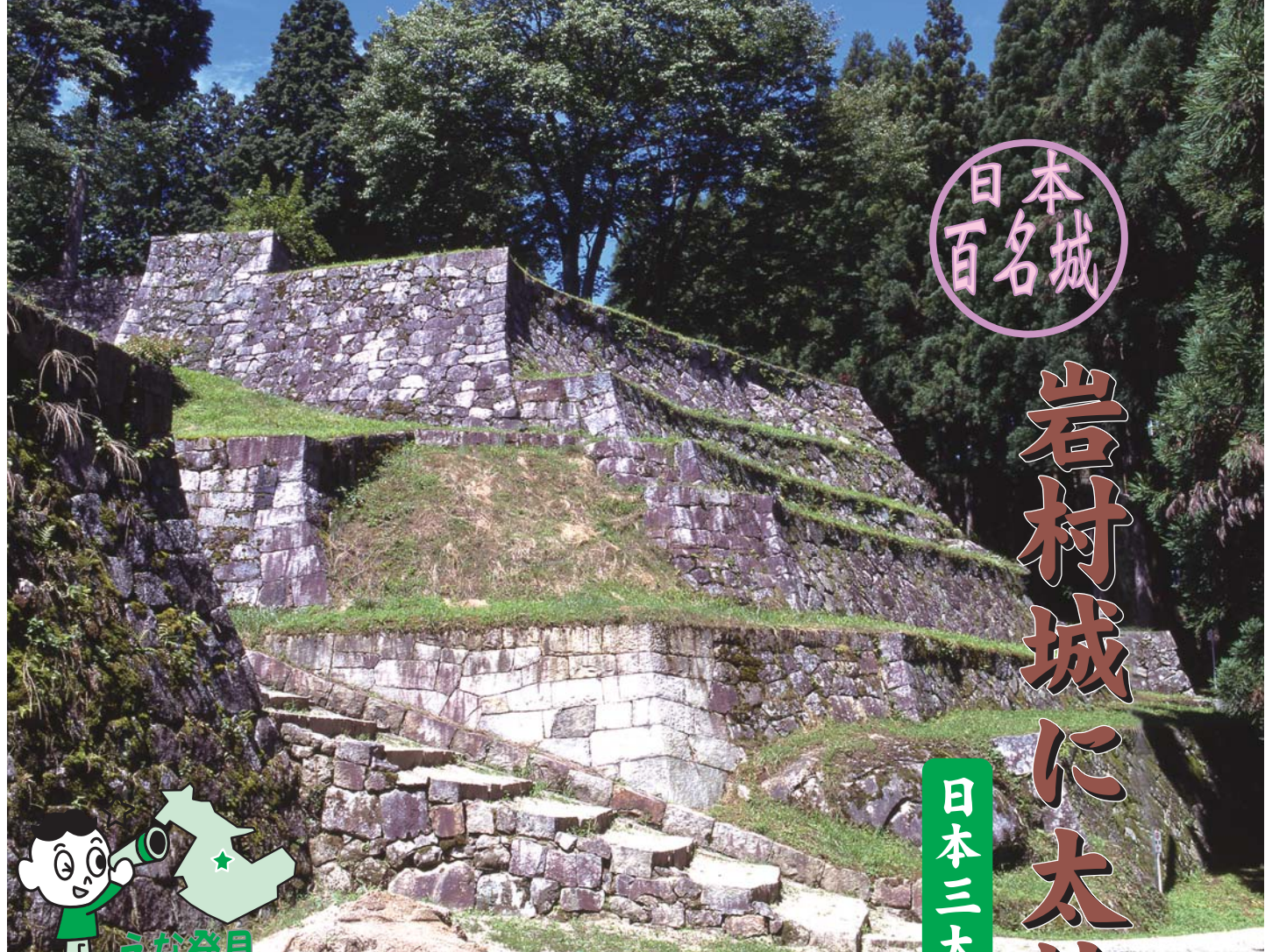
▲岩村城本丸の六段の石垣と東曲輪上り口付近
