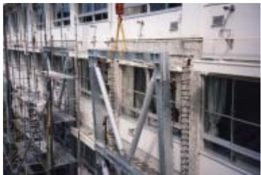
長島小学校の耐震補強工事を実施
