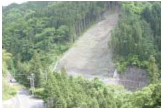
道路災害復旧事業（串原地内川ケ渡木根線）
