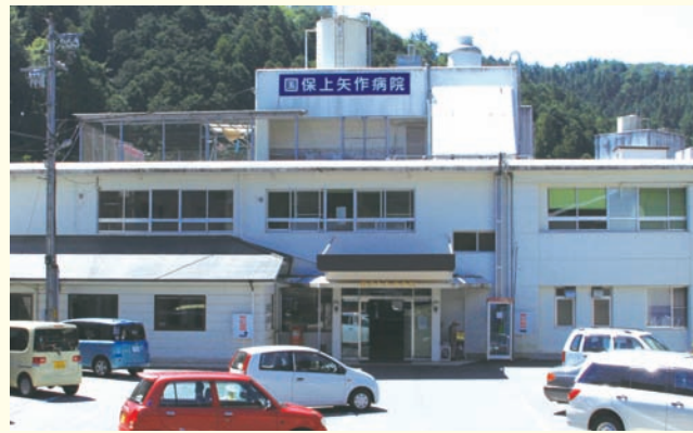
▲昭和52年に開院した国保上矢作病院
