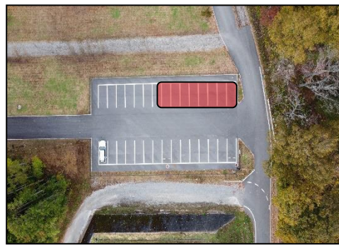
整備予定箇所①
