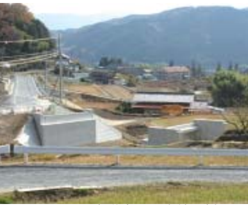
市道寺田石山線の橋りょう(笠置町)
