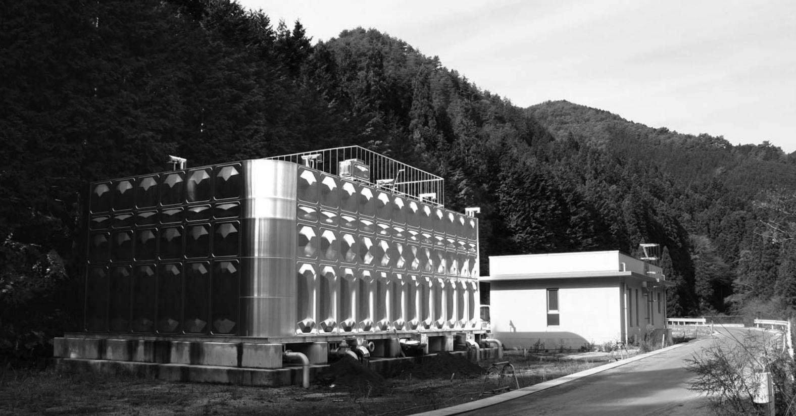
上矢作統合簡易水道事業（上矢作町飯田洞地内）
