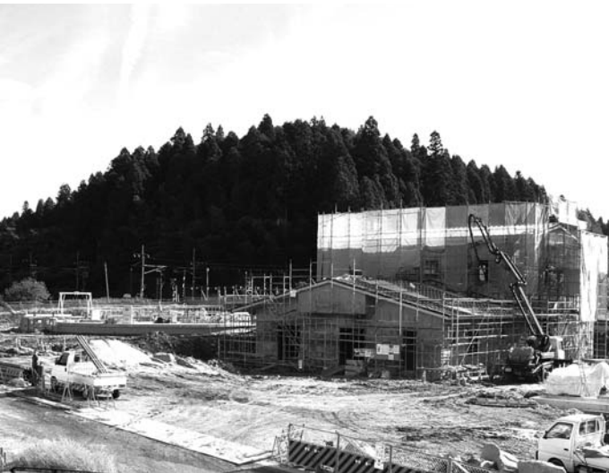
竹折特定環境保全公共下水道事業（武並町竹折地内）
