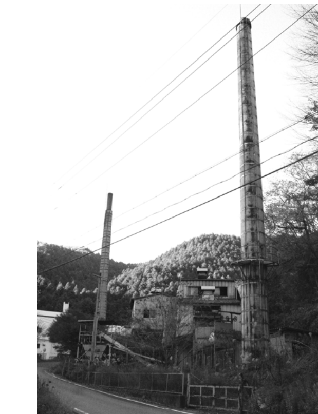
解体される旧恵南清掃センター(明智町地内)
