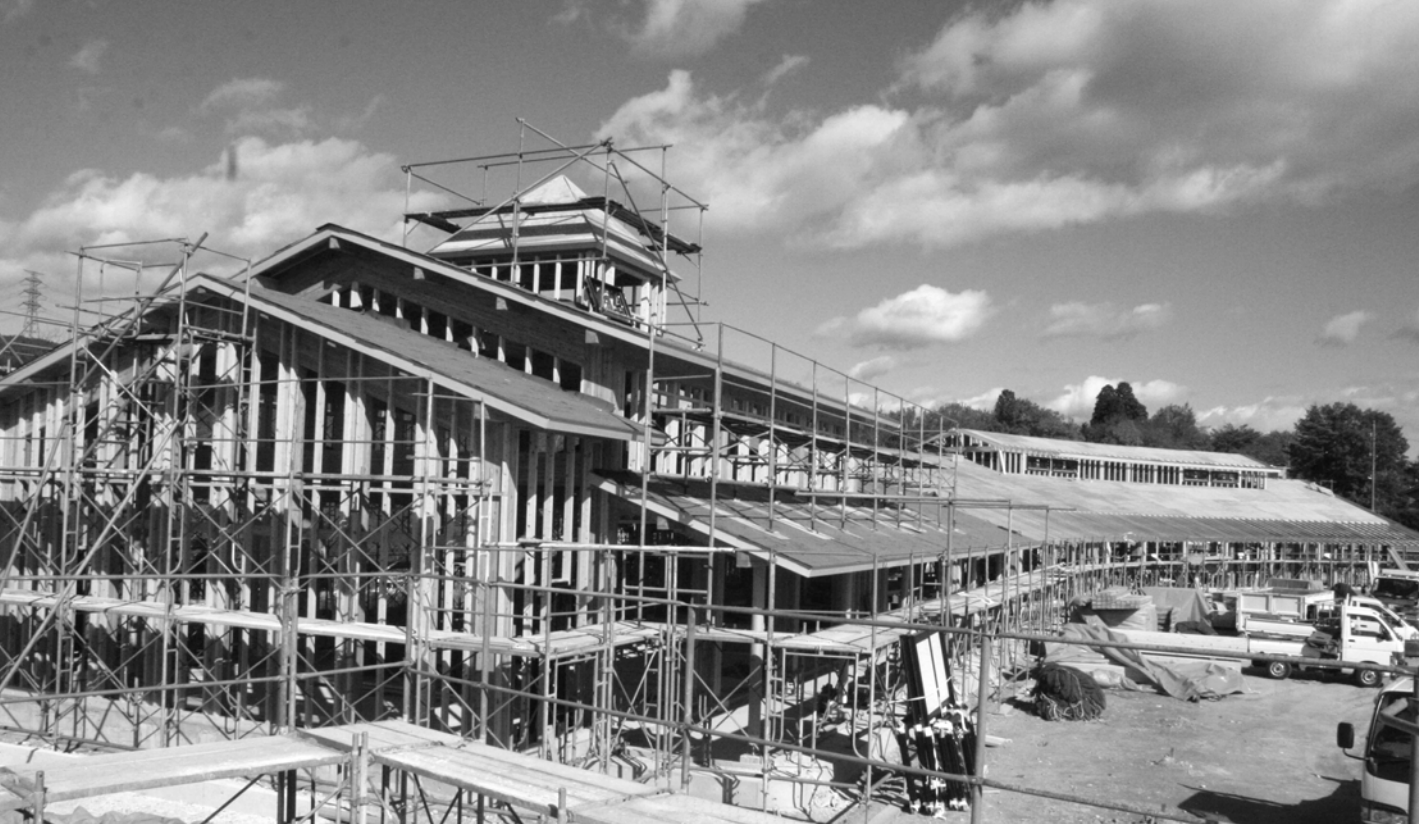
武並保育園建設事業（武並町）
