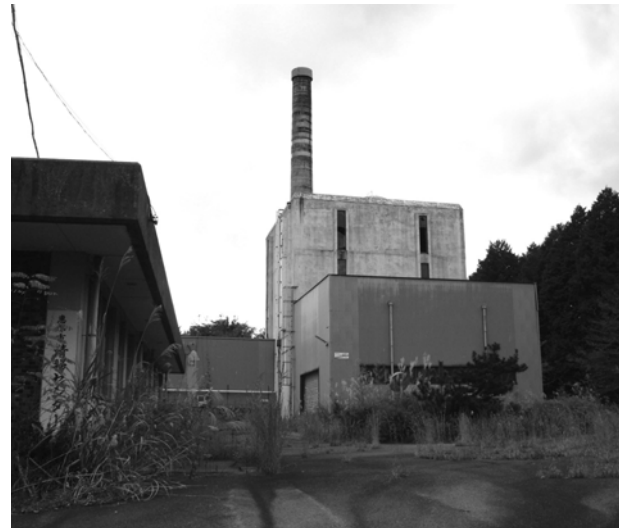
解体される旧恵那清掃センター(長島町地内)
