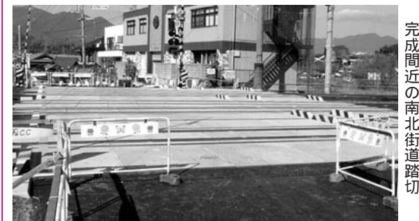
完成間近の南北街道踏切
