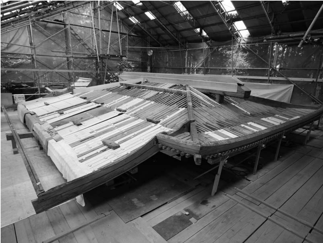
木材の補修が進み屋根が徐々に姿を現し始めた武並神社本殿（平成21年4月30日撮影）
