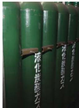
ポンペの中に、不燃ガスが入っている。RDFとRDF炭化物のタンク内には、不燃ガスを充填して事前に火災を防止している
