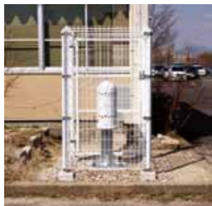
▲恵那総合庁舎に設置されたモニタリングポスト
