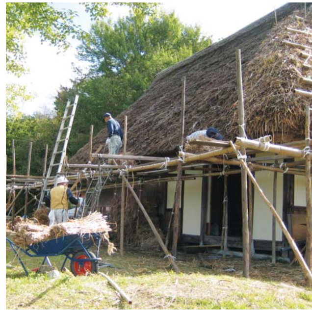
みさと振興委員会による、「茅葺きの家」のふき替え作業。多くの人によって保存されている
