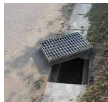
▲鋼鉄製のふた(グレーチング)
