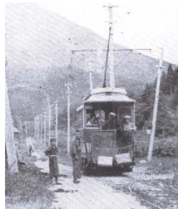
▲浅見氏が開通させた岩村電気軌道の開通当時の電車(場所は東野)
