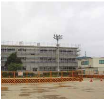
▲武並小の耐震化工事が市内最終となる
