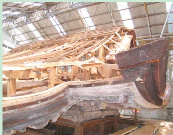
◀檜皮を取り除いた状態の屋根
