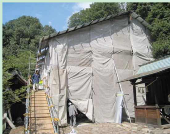
◀工事用の覆屋の中で修理が進められる
