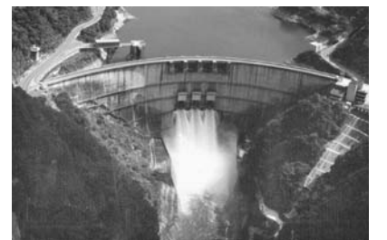
▲矢作ダム(矢作川水系 串原) 日本では数の少ないアーチ式のダムで、放物線を描く美しい形状が特色です。目的は洪水調節、農業・工業・上水の各用水利用のほか、発電も行われている多目的ダムです。
