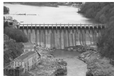
▲大井ダム・発電所(木曽川水系 大井町)
