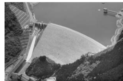
▲阿木川ダム(木曽川水系 東野) 平成3年3月に完成したロックフィルダムで、洪水調節・河川環境の保全と新規利水の供給を目的とした多目的ダムです。
