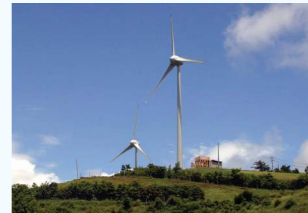
▲上矢作町大船山山頂付近に完成した風力発電施設
