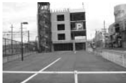
駅西駐車場横のスペース
