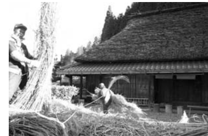
▲ふき替え作業が進む三宅家
