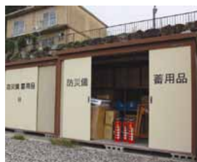
▲防災備蓄倉庫(中野方町)
