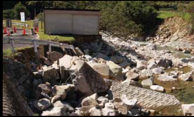
▲河川の護岸を削り取るほどの大きな被害をもたらした
