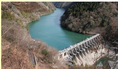
▲ダムは傾斜が急な渓谷に建設された
