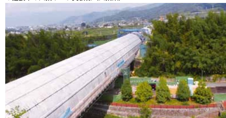
▼建設中の山梨リニア実験線(山梨県)
