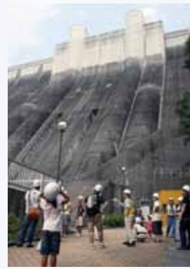
▲小里川ダムの堤体の下からの眺め
