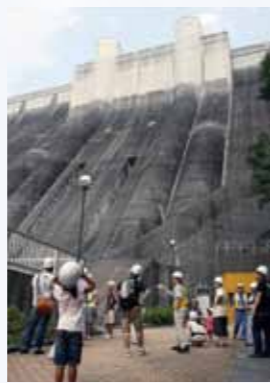
▲小里川ダムの堤体の下からの眺め
