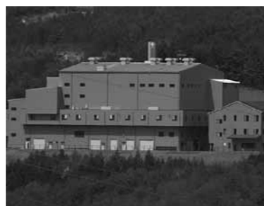
▲築10年が経過したエコセンター恵那(長島町)
