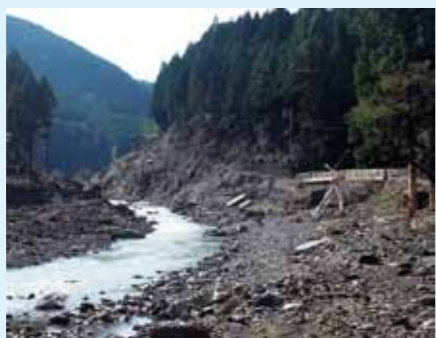
▲平成23年台風第12号の豪雨で山崩れなどの被害を受けた和歌山県田辺市
