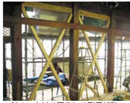
▲斜めに木材で固定して耐震補強
