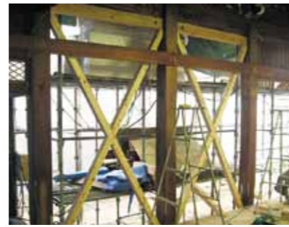
▲斜めに木材で固定して耐震補強
