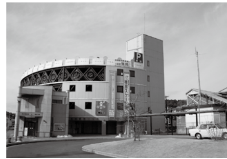
▲恵那駅に隣接し便利な駅西駐車場
