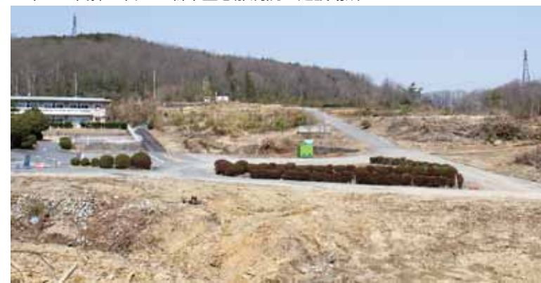
▼木々の伐採を終えた新市立恵那病院の建設場所
