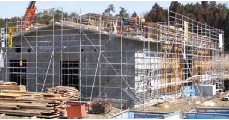
▲岩村町富田に建設中の岩村浄水場
