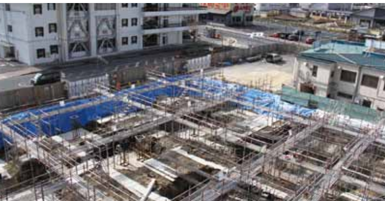
▲市役所の西隣に建設中の新庁舎
