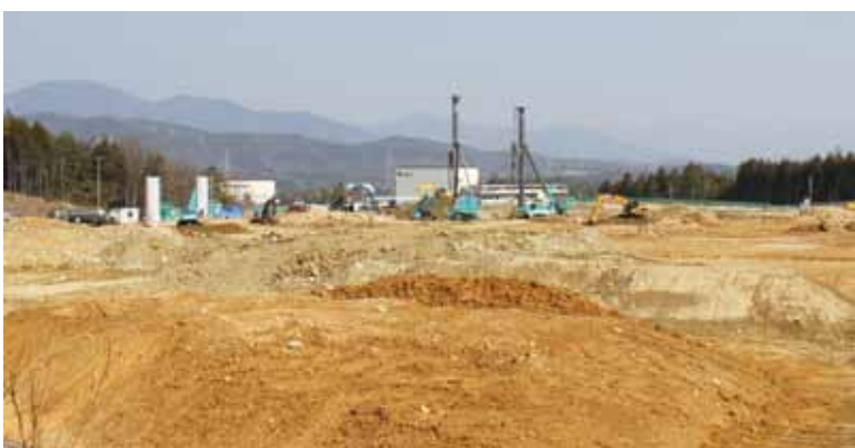
▲分譲が完了し工場を建設中の第3期恵那テクノパーク
