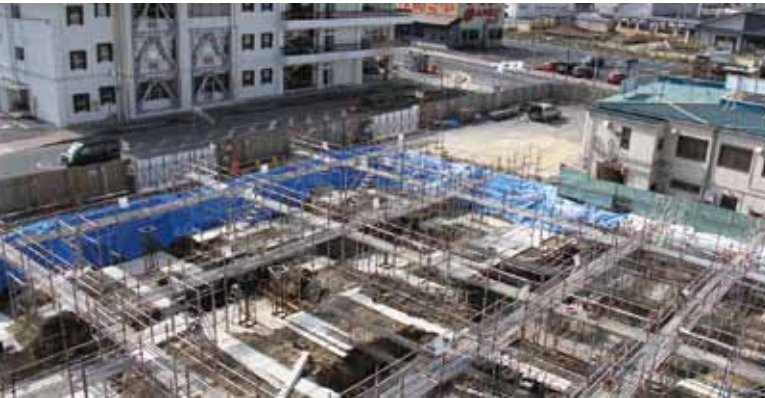
▲市役所の西隣に建設中の新庁舎
