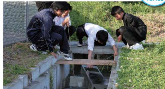
ふれあいエコプラザの横の水路に、小水力発電の装置が設置されました。これは、市小水力利用推進協議会と恵那高等学校科学部が共同で設置したもの。両者は、発電した電気を交流から直流へ変換する基板を製作。今後、より有効な電力供給ができるよう実験を重ねます。
