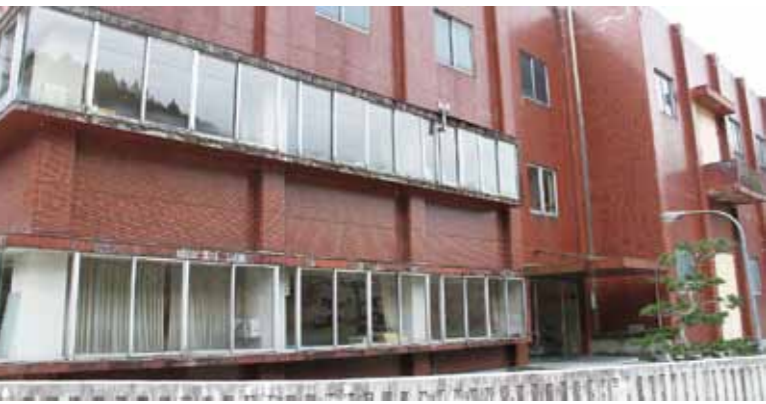
▲窓の補強などの耐震化工事をする市浄化センター
