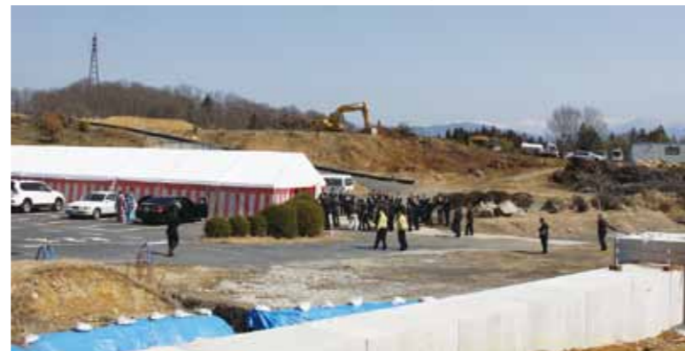
▼建設が始まる現在の市立恵那病院の東側の敷地
