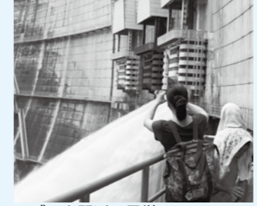
▲ダムを間近で見学
