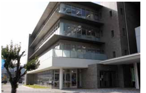
▲完成した市役所西庁舎
