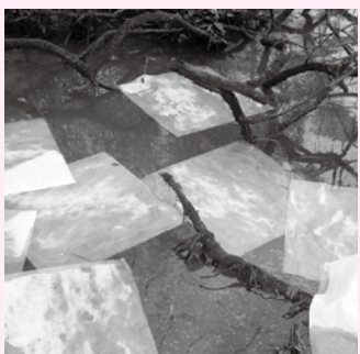
▶河川に流出した油をオイルマットで吸い取る
