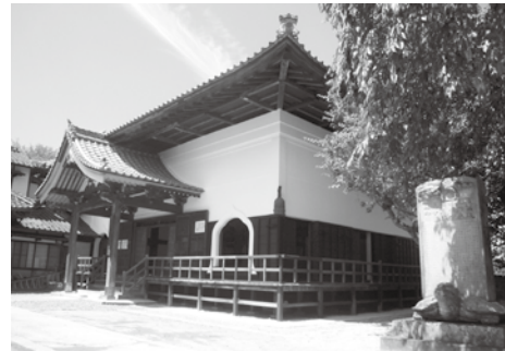
▲修理が完了した浄光寺の本堂
